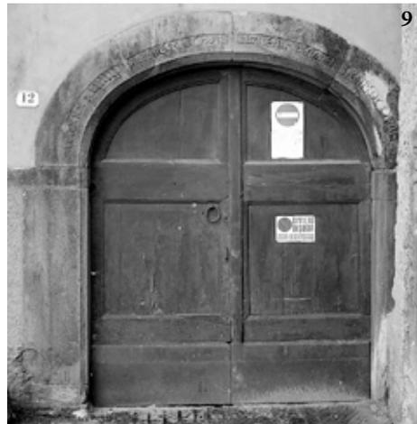
Fig. 7. Garessio, Borgo Poggiolo, SP 213 n. 101, arco ribassato in conci di quarzite multicolore recan-
